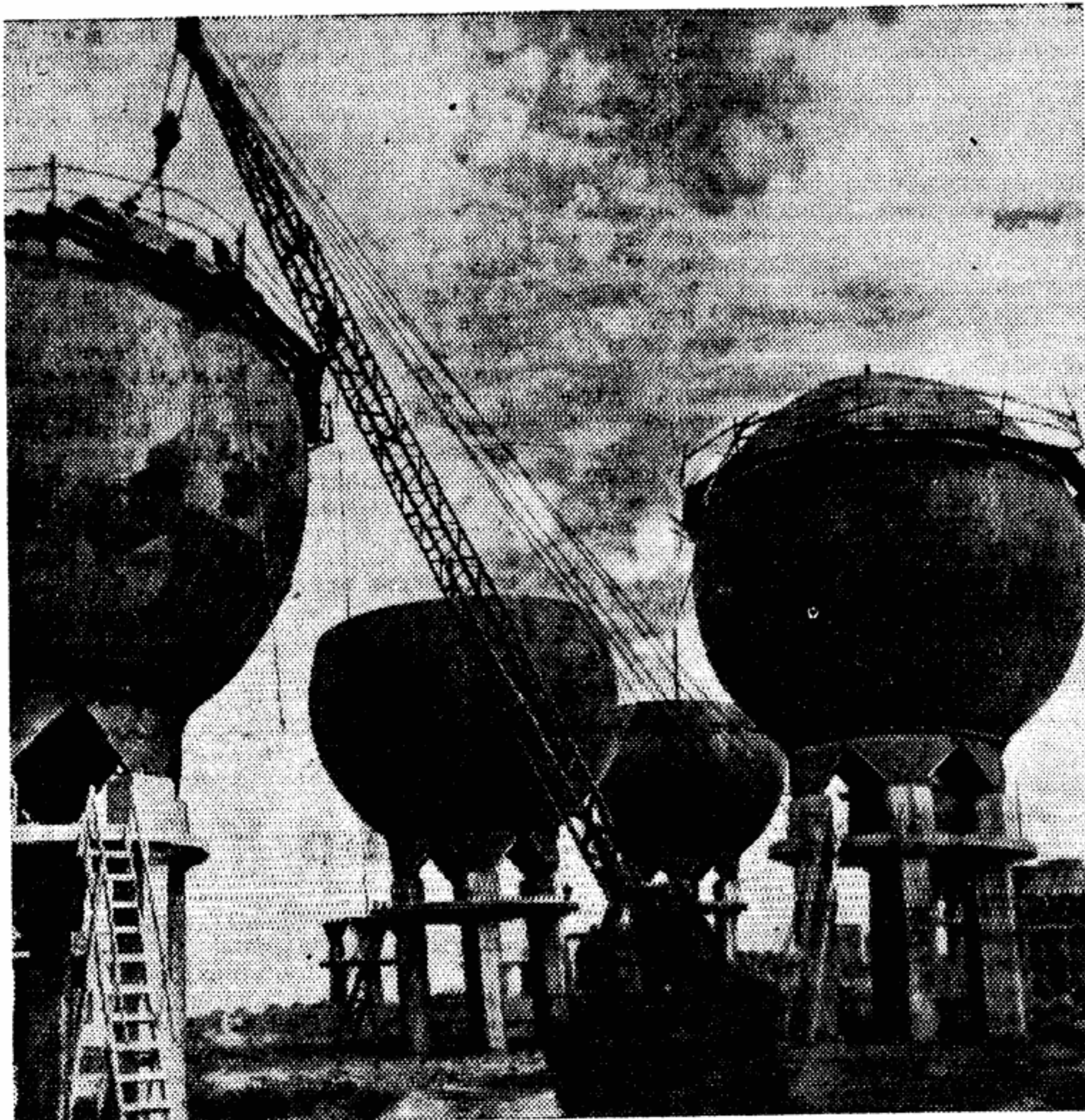
В Омске строится завод синтетических материалов. НА СНИМКЕ: монтаж резервуаров бутана. Фото М. ТРАХМАНА
